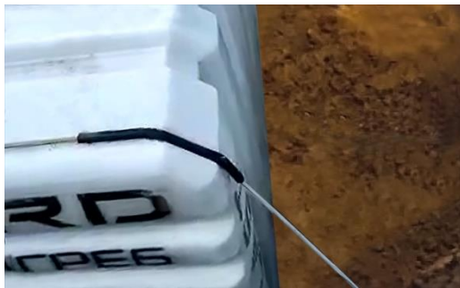
Рисунок 5. Заделка троса
